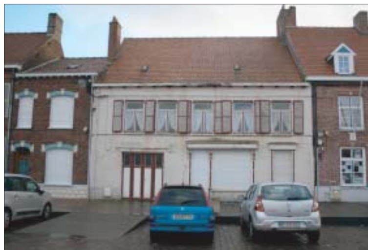
Trois cellules commerciales et un espace pour l'association seront bientôt aménagés dans cette maison de la place Bergerot.
